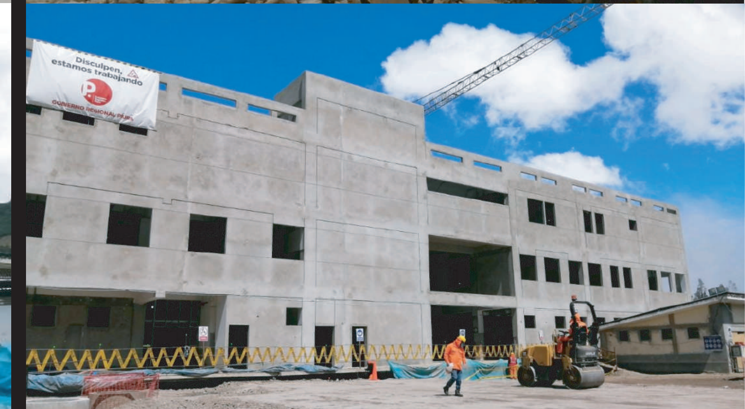
OBRA: HOSPITAL REGIONAL DE HUARMACA LUGAR: PIURA
